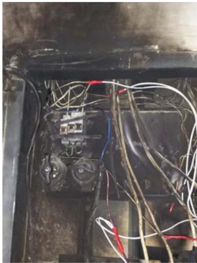
Щит (на фото) был установлен около 15 лет назад и всё это время исправно работал. В этом электроустановке установлены электросчётчик и автоматы на четыре квартиры. В одной из этих квартир из мощных приборов установлен кондиционер, стиральная машина и
